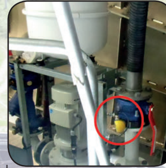
Windkraftturbinen Überwachung des Triebstrang- kühlkreislaufes
